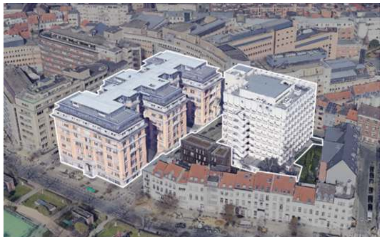
Les deux bâtiments sont pour l'heure occupés par les services administratifs du SPF Justice. © D.R.
